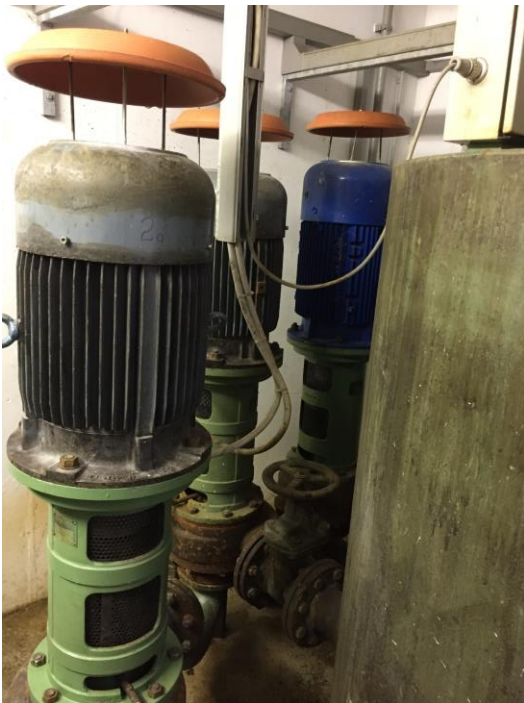
Altes Pumpwerk vor dem Umbau
