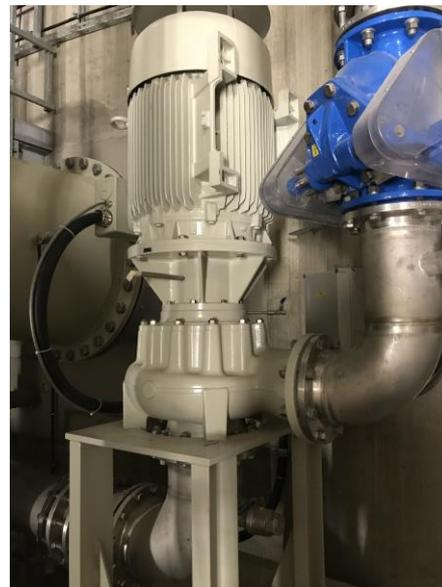
Wartungsfreie vertikal aufgestellte Turo® Freistrom-Pumpe im Pumpwerk Gelsenkirchen. Die hydrodynamische Wellenabdichtung Eurodyn® arbeitet reibungs- und verschleissfrei und zeichnet sich durch eine sehr hohe Betriebssicherheit aus.
