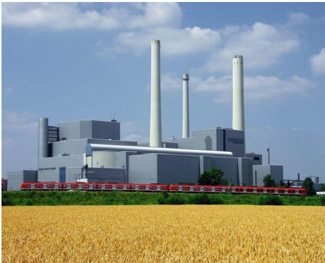
Heizkraftwerk Nord, Foto: SWM
