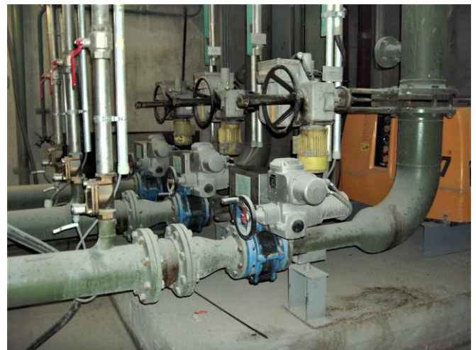
Iris® Blendenregulierschieber DN 100 für die Klärschlamm-beschickung der Zentrifugen im Heizkraftwerk Nord
