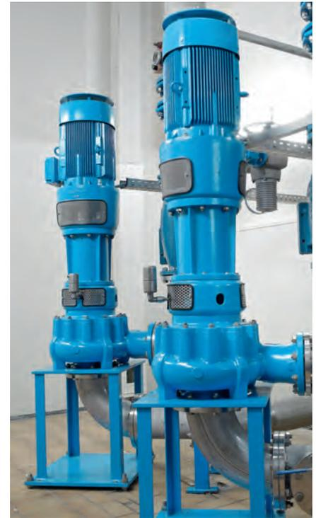
problemas derivados de la acumulación de fibras, completando de este modo la hidráulica Turo® con el nuevo rodete TA para aguas residuales. Se ha tenido especial cuidado en que esta nueva hidráulica sea totalmente integrable en el sistema modular de nuestras bombas Turo® de rodete Vortex. Existe en todos los tipos de construcciones: sumergible, montaje en seco vertical y horizontal, monobloc o con soportes mecánicos, de pozo o cantiléver.
