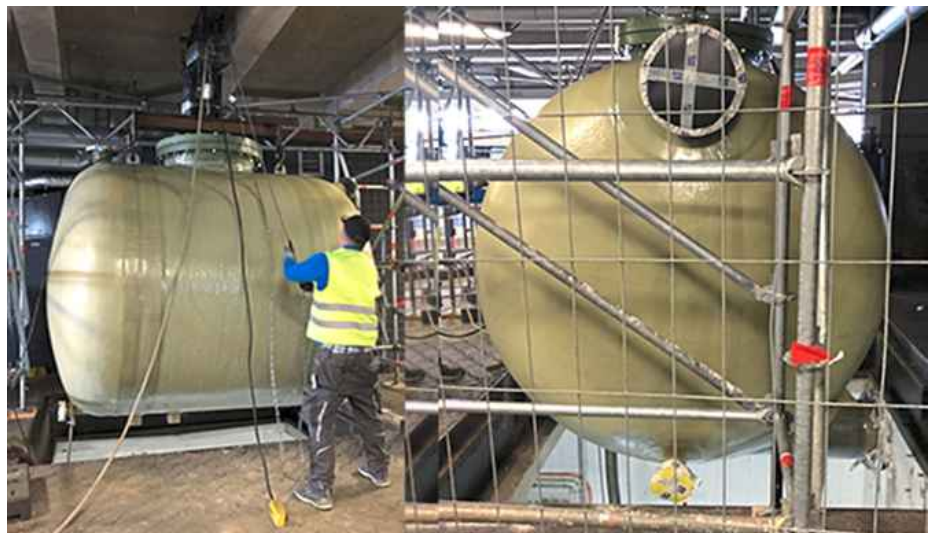
Einbringung neue Pumpvorlagekessel durch Montageöffnung 3 x 3,2 m mit Überbau Terminal 1 Fraport AG
