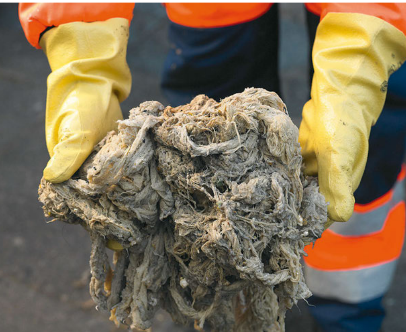
Verzopfungen vor Einbau des neuen Laufrades Bild 1
